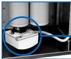
Датчик температуры обратной воды
